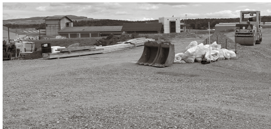
Dammschüttung für Strassenbau
