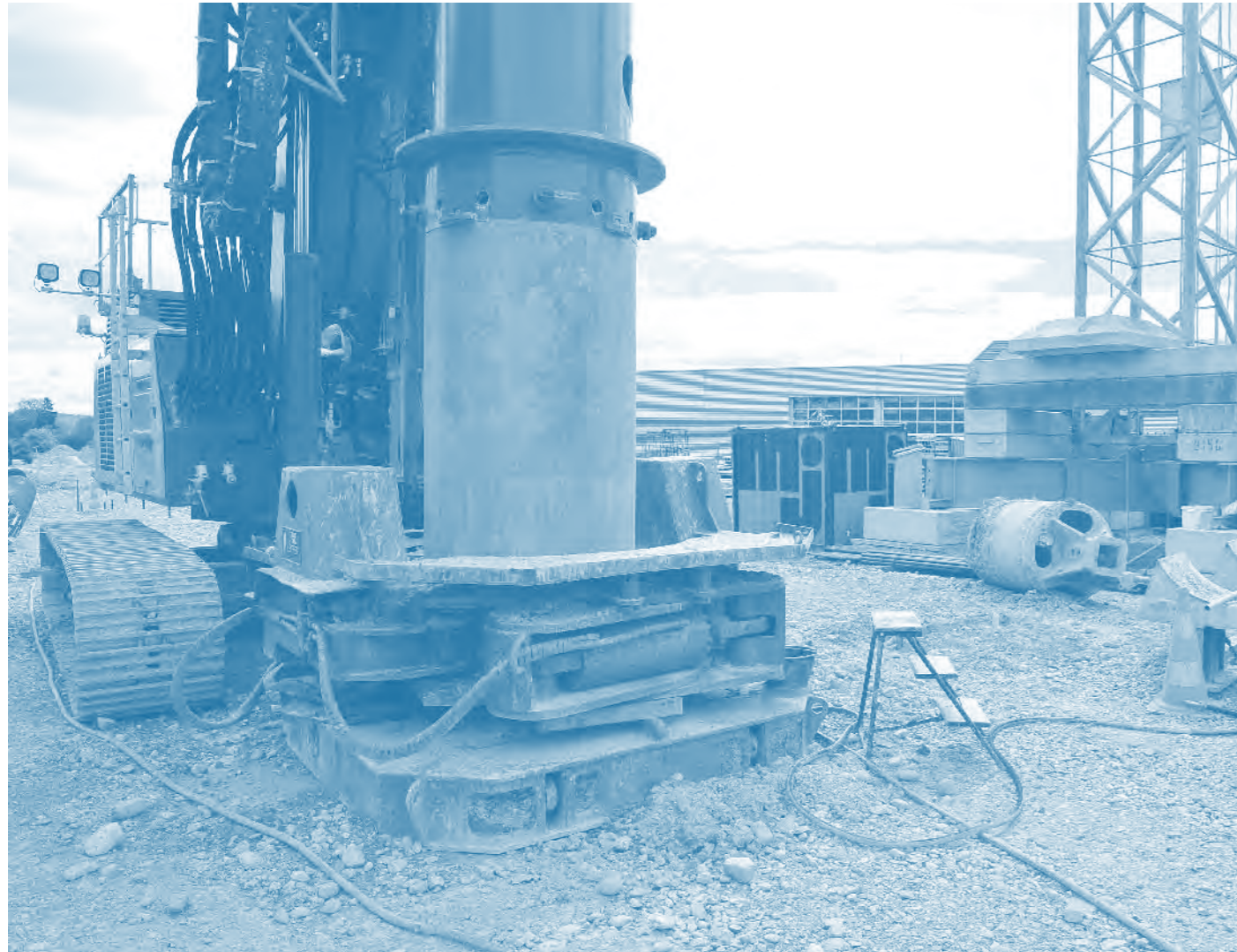
Bohrarbeiten im Industriegebiet. Tiefe Fundamente für die Brückenabstützung
