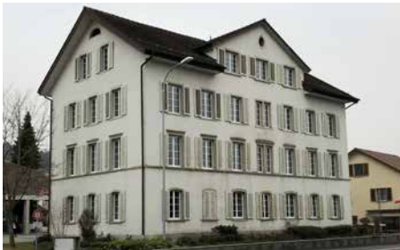
Altes Schulhaus vor der Sanierung März 2022
