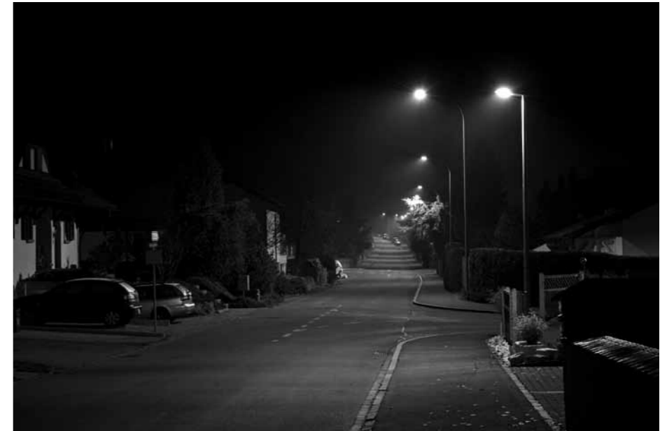
Ab 22.00 Uhr: innert Minuten regelt sich die Leistung der Strassenbeleuchtung an der Südstrasse auf 60 % zurück
