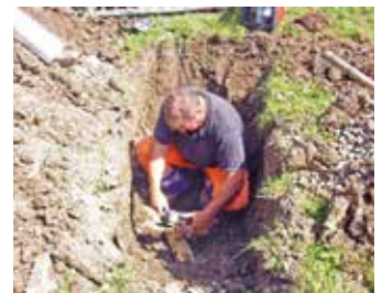
Werkhofmitarbeiter Erich Werder beim Flickern einer Drainage...
