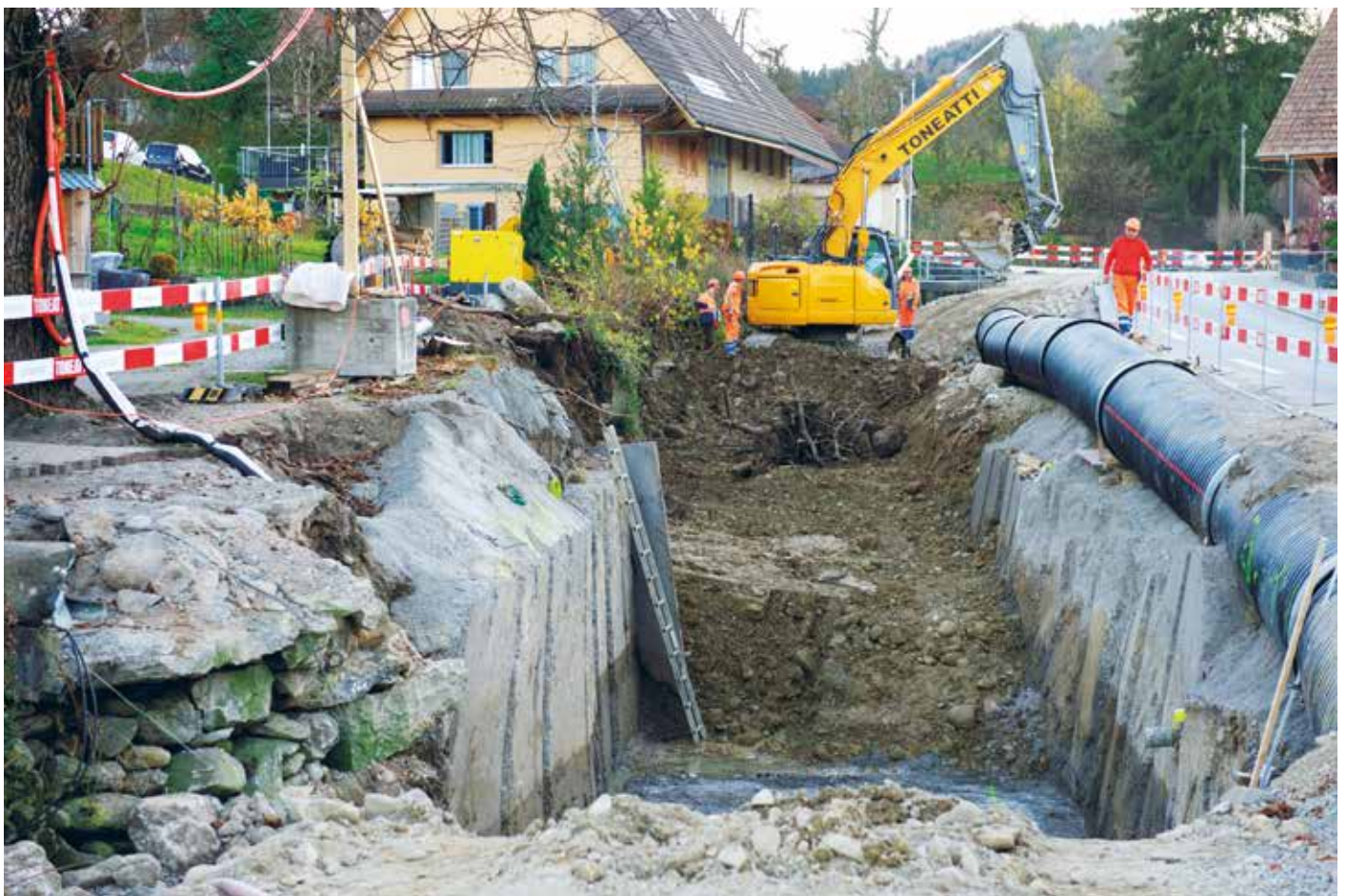
Sohlenabsenkungen und Gerinneaufweitungen am Wissenbach sind bereits jetzt erkennbar
