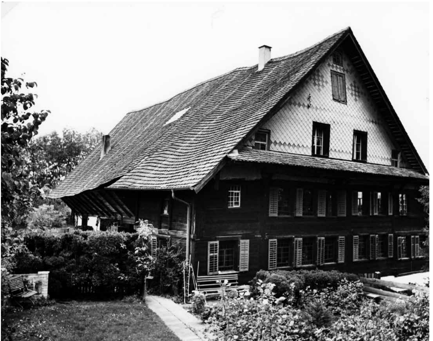
Das Sigristenhaus auf einem Foto von 1977 (Foto Kantonale Denkmalpflege)
