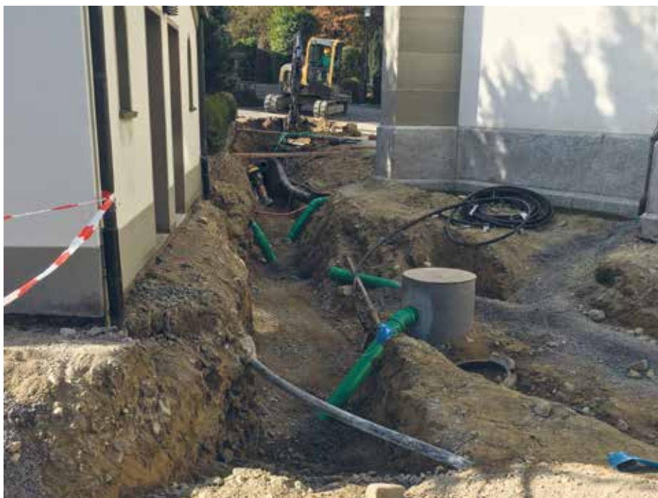
Sanierungen der Kanalisation sowie Belagsflächensanierung des Kirchenparkplatzes und Platzes vor dem Friedhofgebäude
