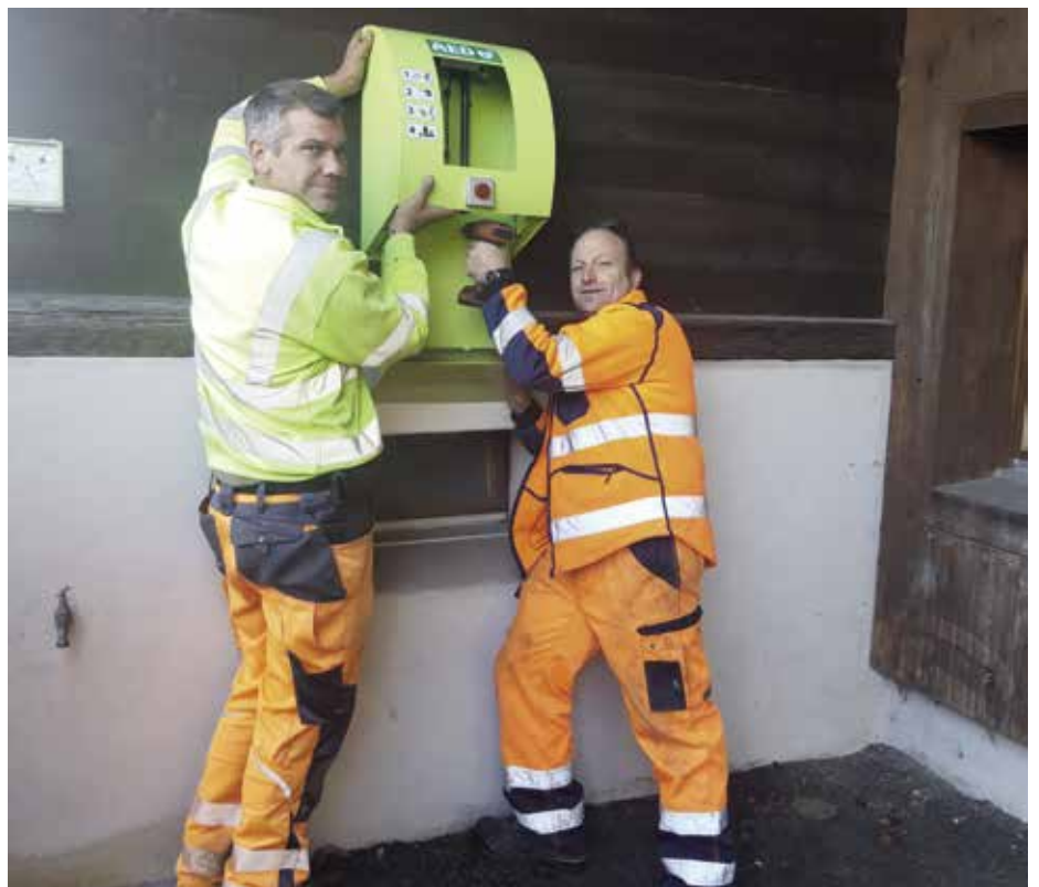
Die Mitarbeiter des Werkhofes René Notter und Othmar Berger montieren den Defibrillator bei der Alten Kirche
