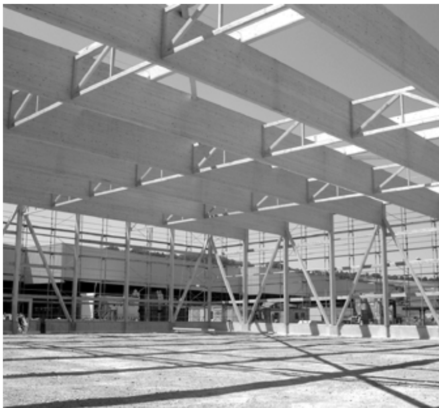
Baustand August 2006 des Logistikcenters der swisspor AG
